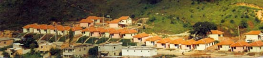
Casas no Bairro Morro Alto, construídas através de mutirões idealizados e executados com apoio da Marreta.
