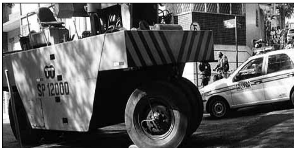
Máquina de recapeamento de asfalto esmagou a cabeça e o tórax do operário
